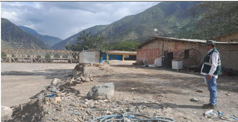
FIGURA N°02: EN EL RECORRIDO SE OBSERVA QUE EL RIO, EN SU MARGEN IZQUIERDA VIENE AFECTADO VIVIENDAS, EROSIONANDO BASES DEL PUENTE.
